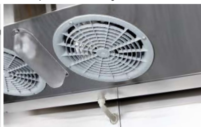
Dynamische koeling met ventilator
